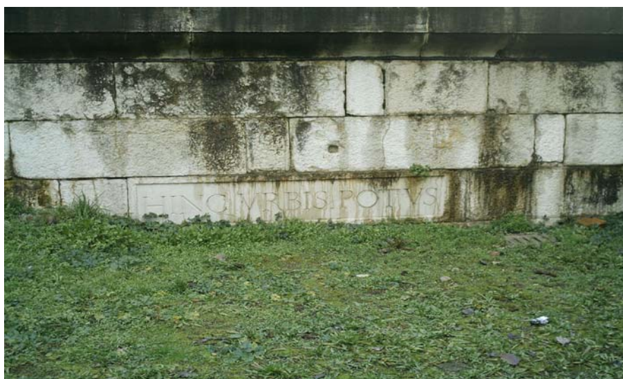
LA PRESA DELL'ACQUEDOTTO IN VIA GARIBALDI
